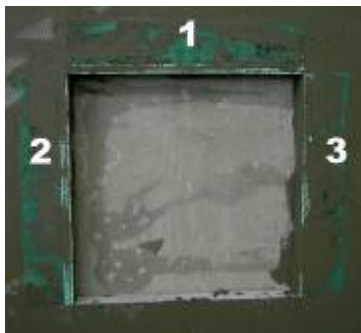
Volgorde voor het plaatsen van profielen bij lijsten en muuropeningen
