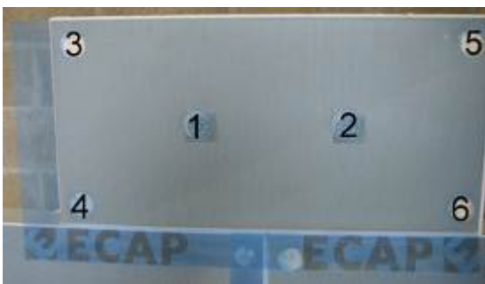
Volgorde voor het plaatsen van de pluggen
